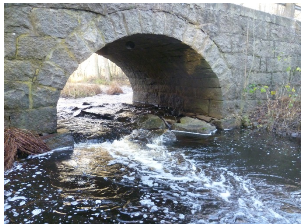
Vandringshinder 11 anses inte behöva åtgärdas.
