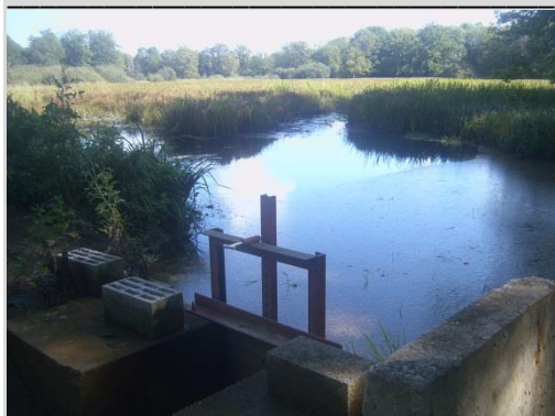
Figur 18. Reglerbart dämme vid våtmark .
