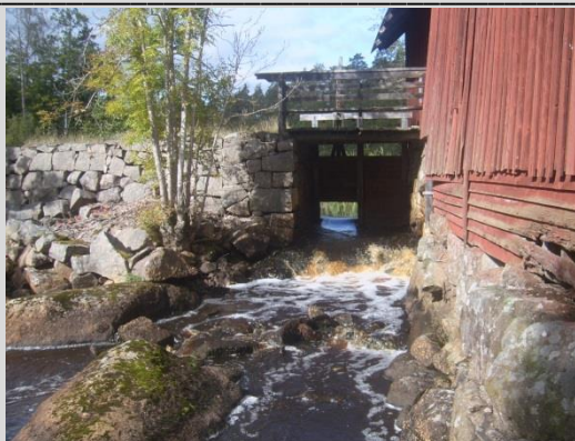
Figur 61. Inges damm sett mot utloppet. Mitt i dammen finns ett mindre hinder som skulle kunna förbättras genom att bredda utskovet och höja ytan nedströms med sten.
