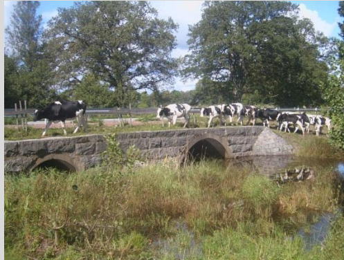
Figur 22. Grova träd kantar ån. Bron vid den större vägen består av två ingjutna trummor.
