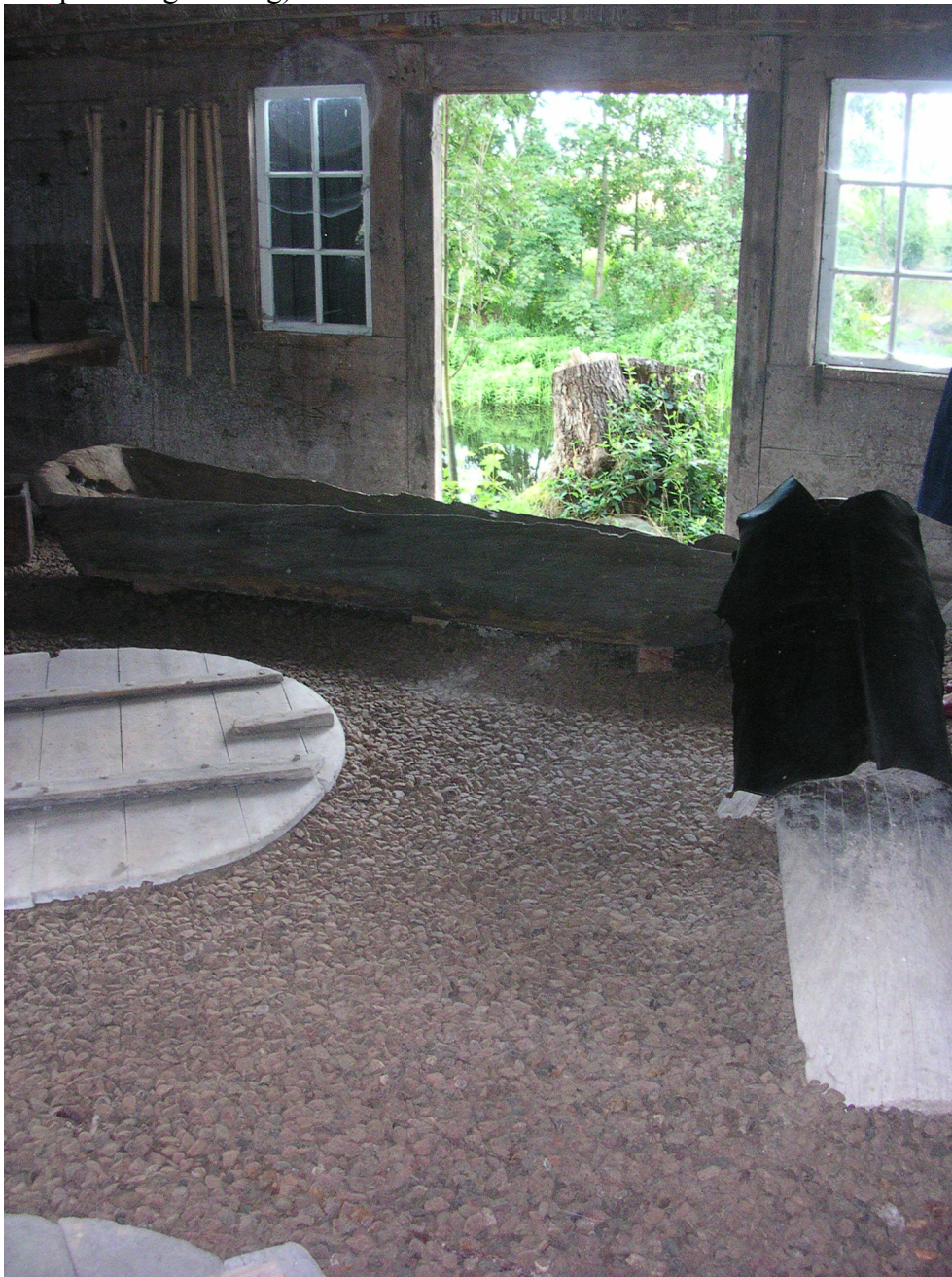
Interiör från Holmskvarns garveri vid Hagbyån - länets bäst bevarade garveri, utanför syns Hagbyån. Foto: Coco Dederling 2009
