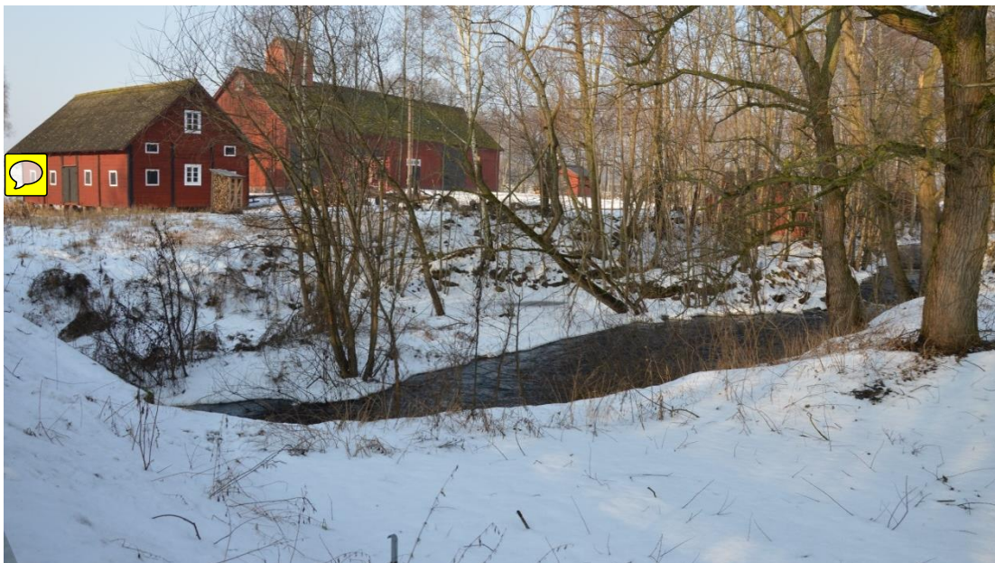
Figur 5. Foto av sedimentfällan i dagsläget.
