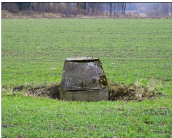
Anlägg en vegetationsbevuxen yta kring ytvattenbrunnen för att förhindra erosion som denna.
