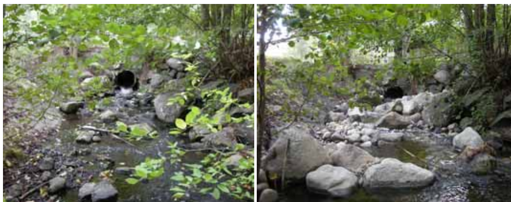
Figur 8. En fellagd brotrumma stoppade tidigare all fiskvandring i Sågsjöbäcken, Stockholms län. Efter tröskling nedströms med stenmaterial togs fallhöjden ut på en längre sträcka. Nu passerar om vårarna både lekvandrande gädda och abborre. Foto: Tobias Fränstam
