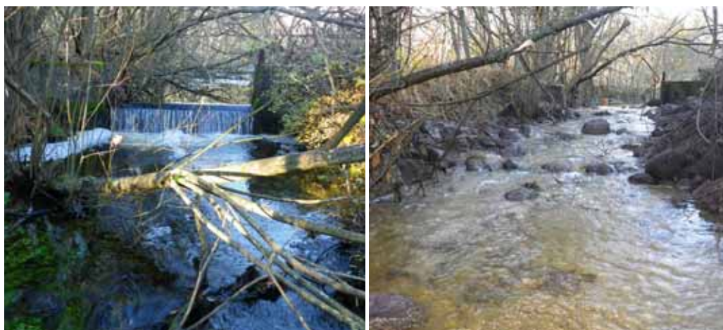
Figur 7. Till vänster damm som utgör vandringshinder för svagsimmande fiskarter (id, abborre, gädda med flera). Till höger samma plats efter fiskevårdsåtgärd i form av tröskling med stenmaterial. Foto: Lars Vallin
