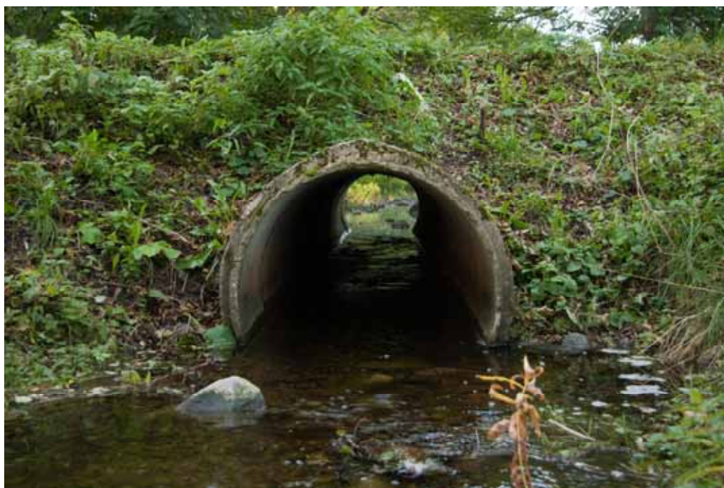
Figur 9. I stället för att tröska nedströms en fellagd brotrumma är det oftast bättre att byta ut befintlig trumma och se till så den nya placeras på rätt sätt. Trumman på bilden är föredömlig eftersom den är delvis nedgrävd och därmed inte skapar något hinder. Foto: Micael Söderman
