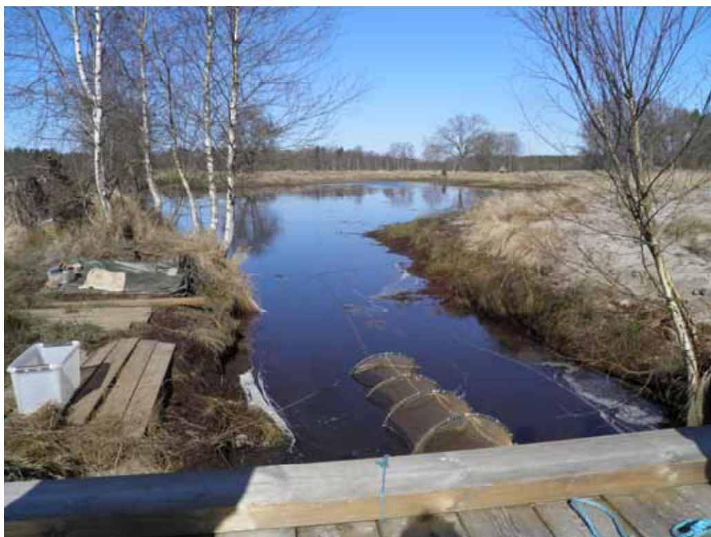
Figur 6. Foto över den breddade åfåran vid Lervik, en åtgärd som under 2008 genomfördes i regi av Länsstyrelsen i Kalmar län. Foto: Jonas Nilsson
