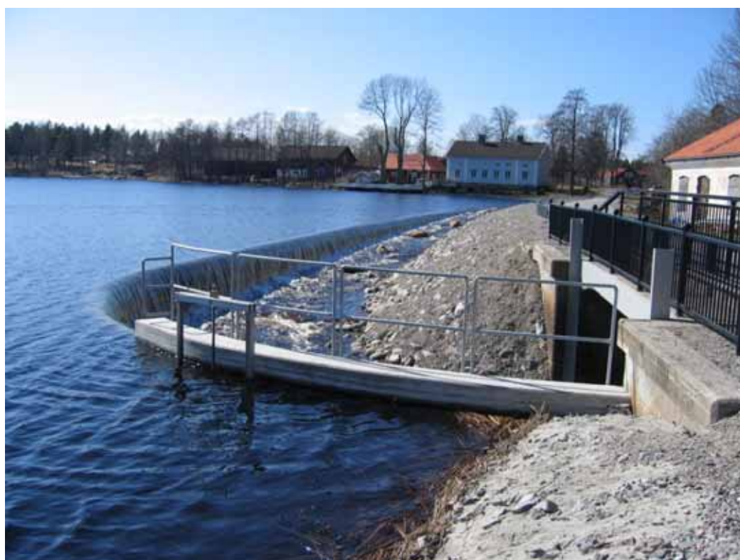
Figur 10. Omlöp/inlöp vid utloppet ur Storfjärden i Gävle kommun. Fiskvägen skulle kunna förbättras genom iläggning av mer stenmaterial som bromsar vattnets hastighet och skapar viloplatser för fisken. Foto: Lars Ljunggren
