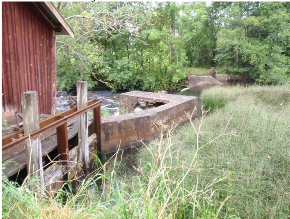
Bild 32. Det andra utskovet till kraftverket i främre delen av bilden.
