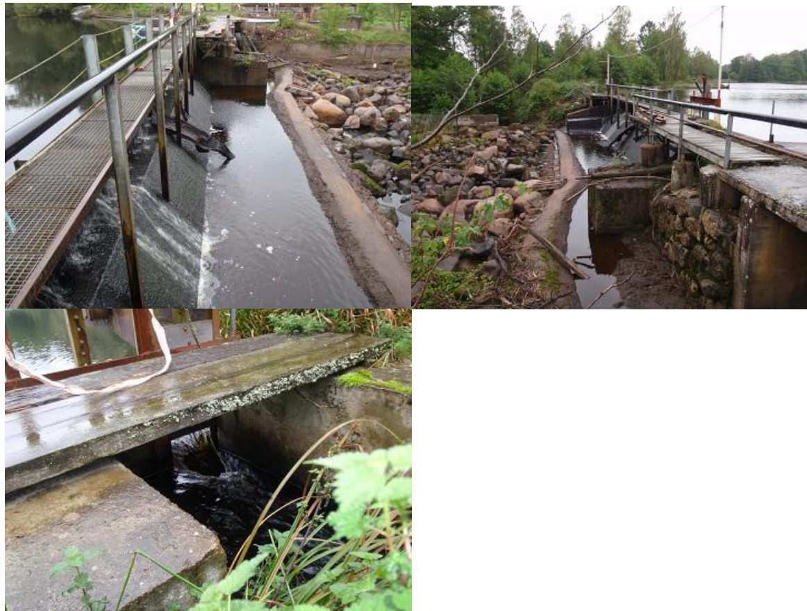
Bild 5-7. Vandringshindret vid Kölbygärde samt utskovet (bild 7).
