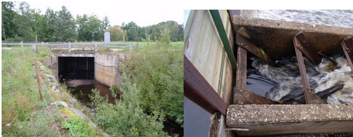
Bild 10 och 11. Det stora utskovet med torrfåra samt utskovet vid denilrännan (bild 11).
