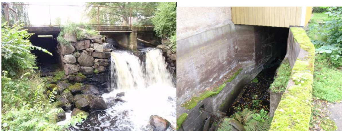
Bild 27 och 28. De tre utskoven visar i bild 27 samt delar av den övre torråran från kraftverket (bild 28).
