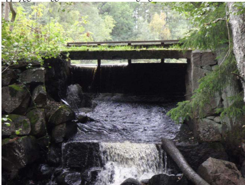
Bild 23. Hålldammen östra vandringshinder.
