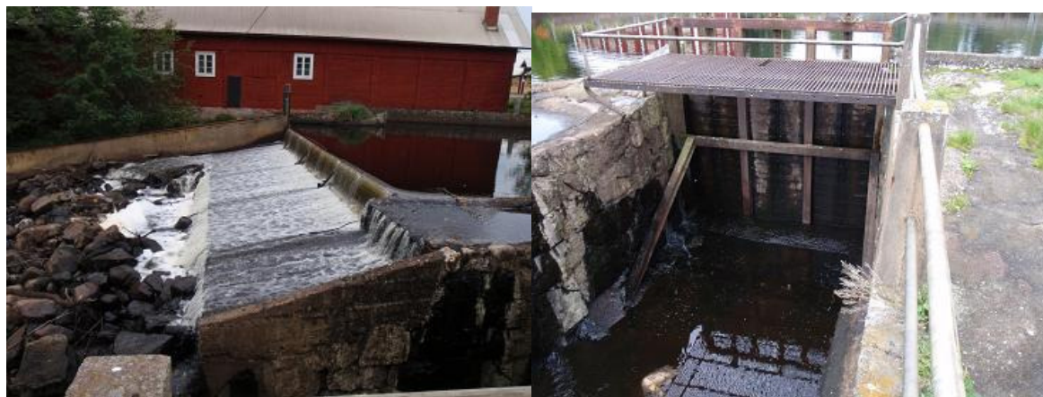
Bild 8 och 9. Vandringshinder vid Krankelösa och det lilla utskovet.
