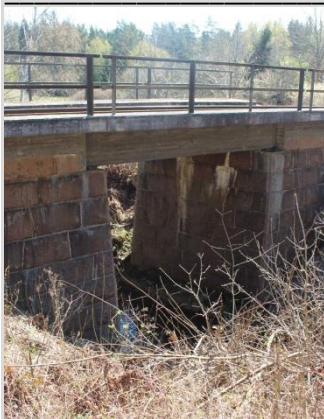
Figur 25. Järnvägsbron över den djupt nedskurna Nävraån.
