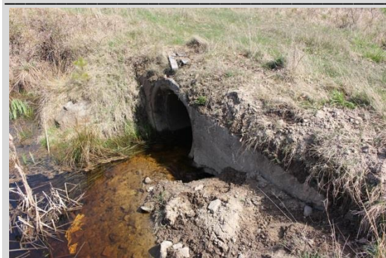
Figur 27. Dammen har en betydelse som reglermagasin i Nävraån. Utloppet bör förbättras så fisk kan passera dammen. Utloppet har två trummor i olika höjdnivå men bara en är i funktion.
