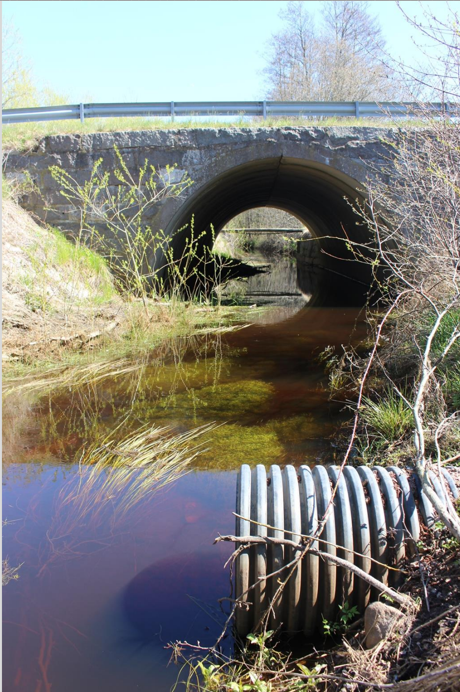
Figur 25. Större dagvattenrör mynnar strax uppströms bron i Lindsdal. Flödet var lågt vid tillfället. Vattnet avvattnar troligen hårdytor i samhället.
