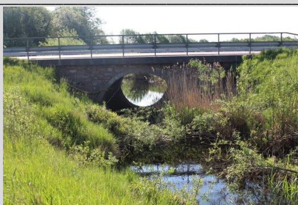
Figur 20. EU-skydds-zoner uppströms väg E22, vägbron består av en gjuten konstruktion med heltrumma.
