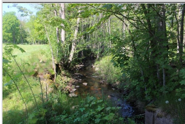
Figur 28. På sträckans slut finns ett gjutet dämme (syns i nedkanten) i en mindre fåra.
