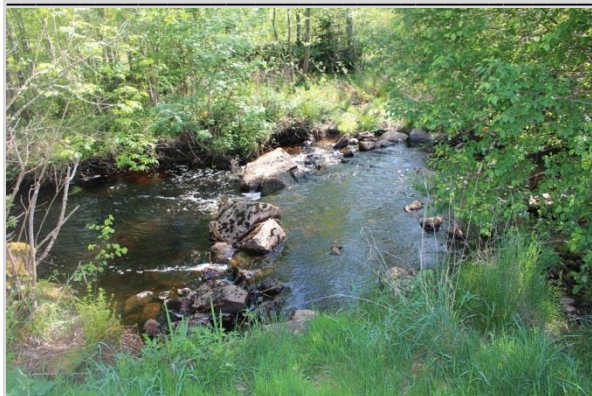
Figur 32. Små partier med snabbare vattenhastighet finns på sträckan. Bilden visar hur man byggt upp med sten, troligen för att säkra vattenflöde uppströms. Inget hinder skapas för fisken men det skulle gå att förbättra platsen genom att sprida ut stenen.
